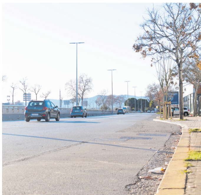
Imatge recent d'un tram del Portal Sud /DS
