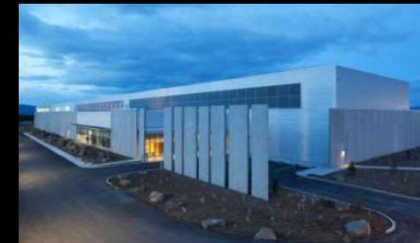
Facebook OCP Prineville DataCenter PUE = 1.06
