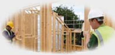
Easy Timber Frame From Benfield ATT
