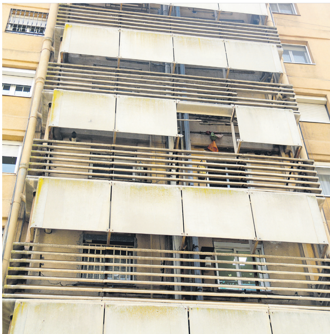
Un edifici amb amiant a Badia del Vallès / CEDIDA (ACN)
