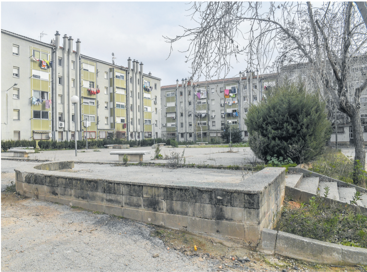
L'estat d'un dels habitatges afectats per aquestes deficiències / LLUÍS FRANCO
