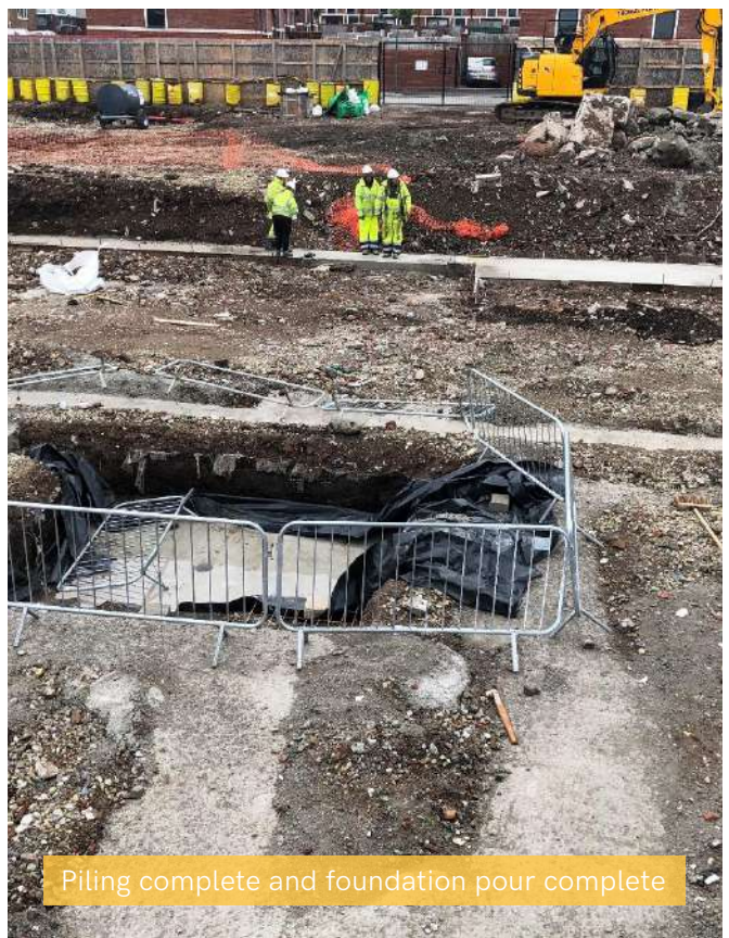
Piling complete and foundation pour complete
