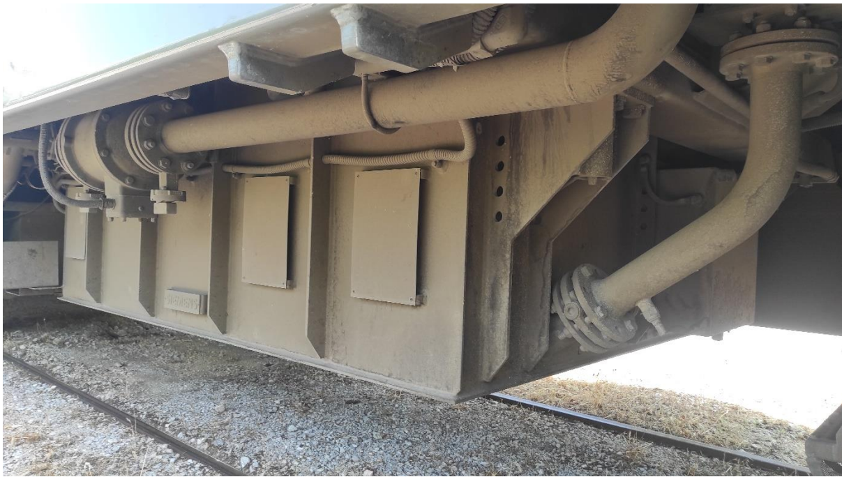
Εικόνα 11: Ο Μετασχηματιστής 25.000 Volt της Ηλεκτράμαξας, στερεωμένος στο πλαίσιο (σασί) της, βάρους περίπου 9 τόνων. Διακρίνεται η δεύτερη αντλία κυκλοφορίας του ψυκτικού υγρού και οι εξωτερικές του σωληνώσεις.
