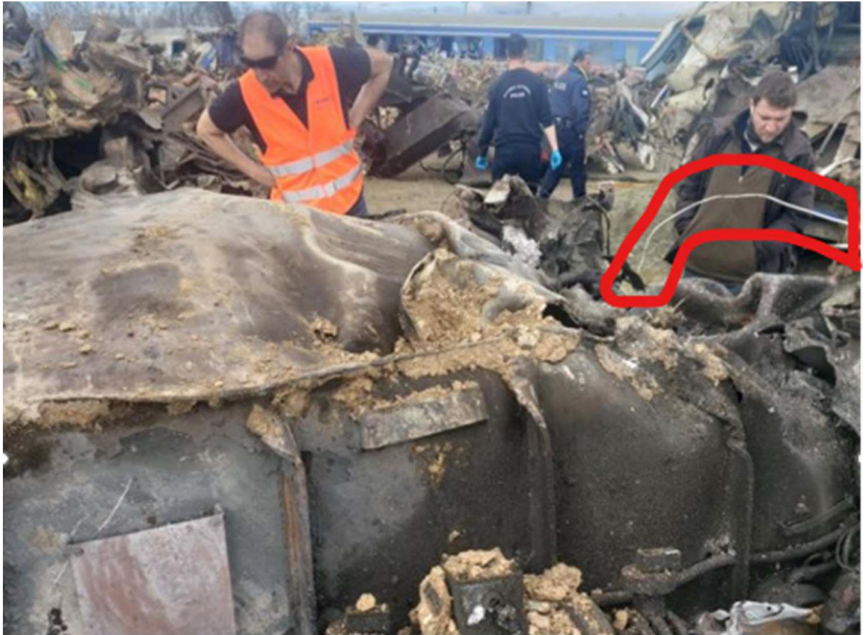
Εικόνα 21. Μετασχηματιστής επιβατικής ηλεκτράμαξας 120023 με εμφανή φουσκώματα από εσωτερική υπερπίεση και τον αποξηλωθέντα αγωγό 25kV του δικτύου, ακόμα σε επαφή με αυτόν
