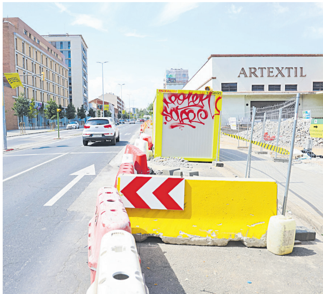
Obres al carrer de Quevedo, per obrir el pati de l'Artèxtil / AINATORRES
