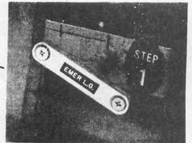
STA 723 L & R
