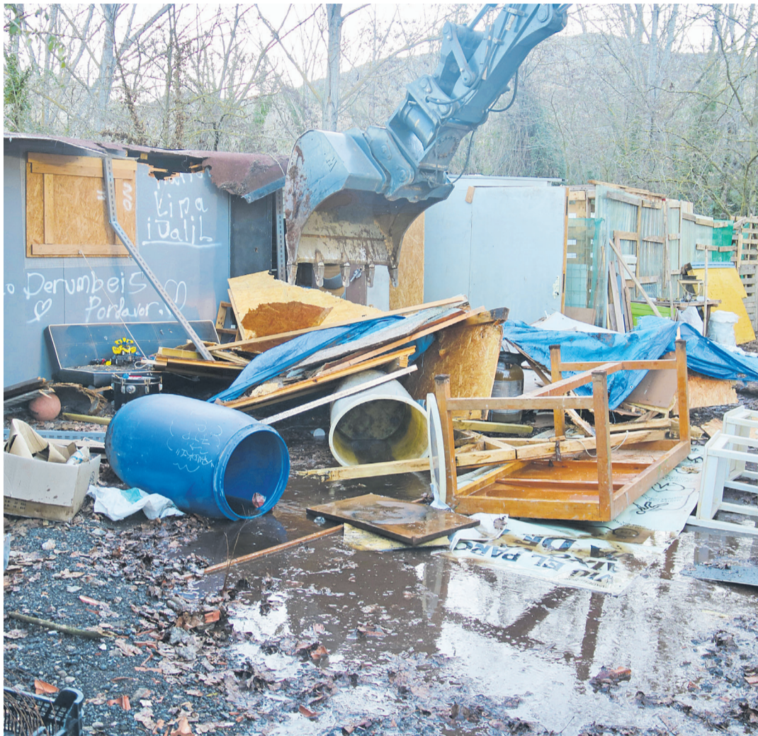
Demolició ahir d'una part de les barraques a la zona / ACN
