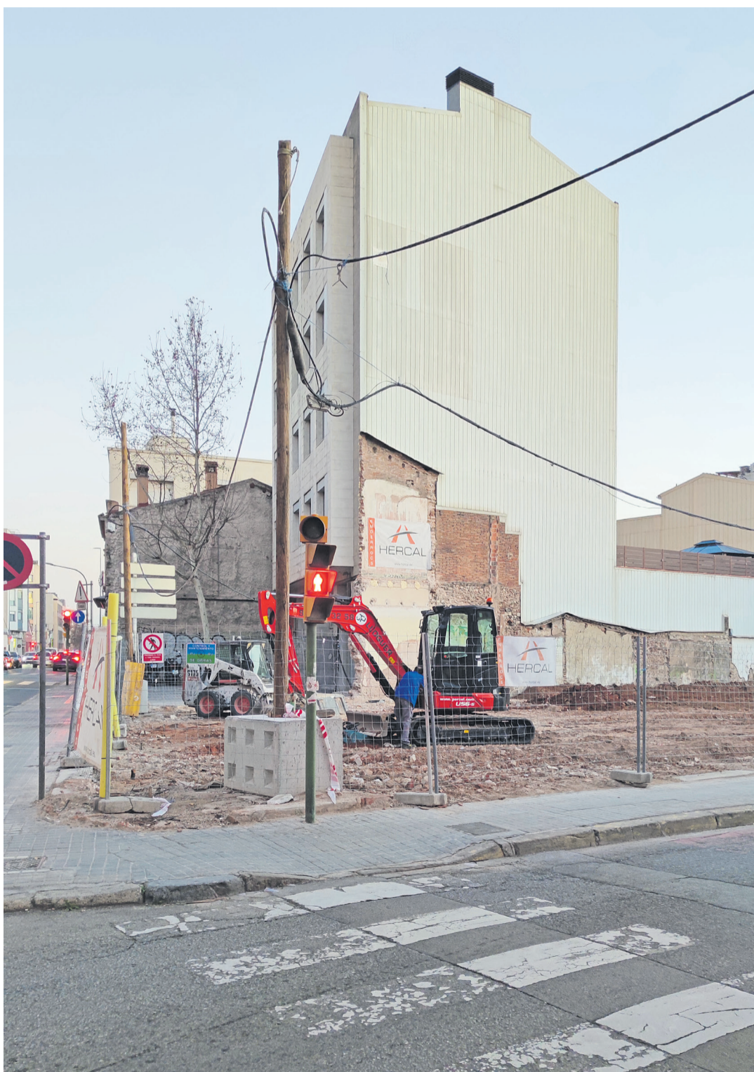
Fa unes setmanes informàvem de l'inici de l'enderroc de l'edifici que hi havia a la carretera de Barcelona, cantonada carretera de Molins de Rei. Allà hi havia hagut el mític bar El Diluvio. L'establiment formava part del Patrimoni sociocultural i etnològic del Catàleg de patrimoni de Sabadell. Doncs ara ja no en queda res. Això sí, una placa ho recordarà quan s'aixequin nous habitatges / D.S.
