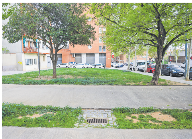
S'hi instal·laran tanques, baranes i paviment de seguretat / DS
