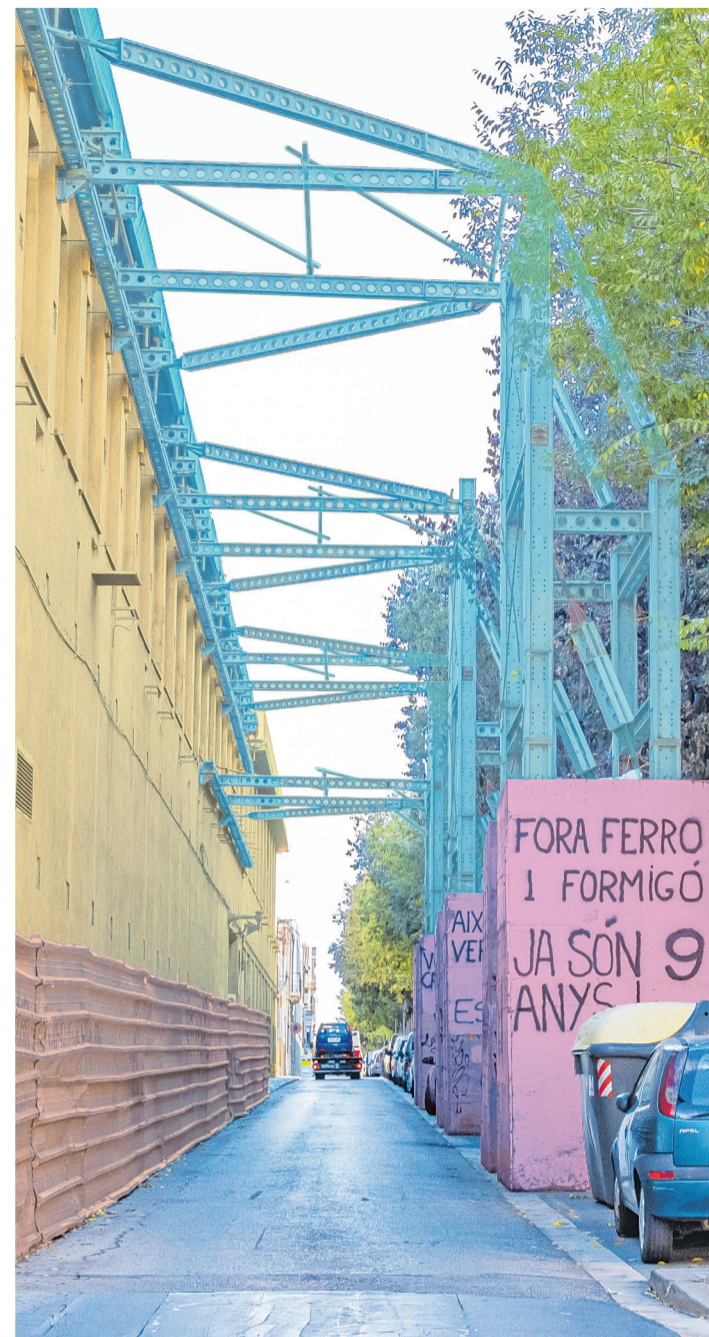
● 1 - Façana ● 2 - Estructura metàl·lica ● 3 - Formigó ● 4 - Voreres
