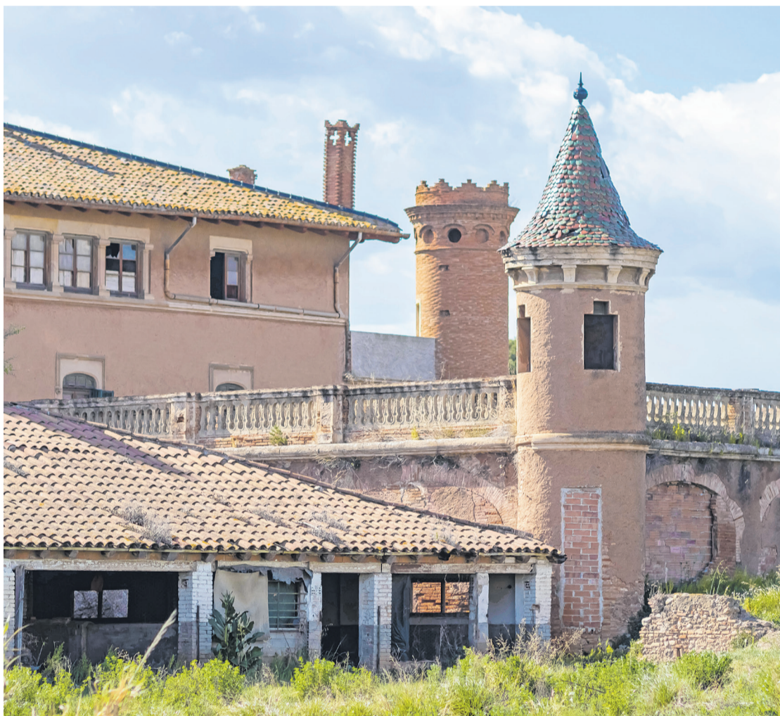
Detall de la Torre d'en Feu / AINA TORRES
