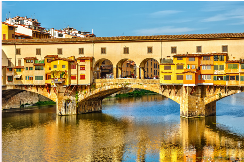
Il Ponte vecchio
